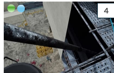
高所からの工具落下
