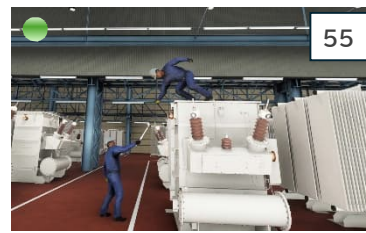
大型変圧器上作業の転落
