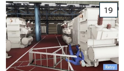
昇降台使用中の墜落
