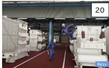
大型変圧器上作業の転落
