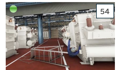
昇降台使用中の転落
